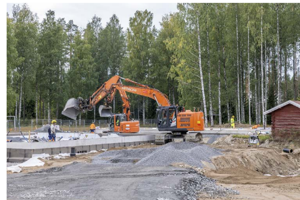
Majoitusrakennusten pohjatyöt ovat käynnissä ja seuraavaksi pystytetään sääsuoja.
