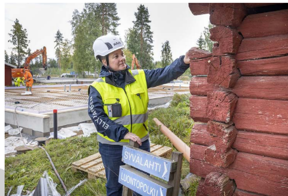
Rakennuttajainsinööri Maija Linnala tutkii säilytettävien vanhojen aittojen kuntoa. Osa hirsistä vaihdetaan.
