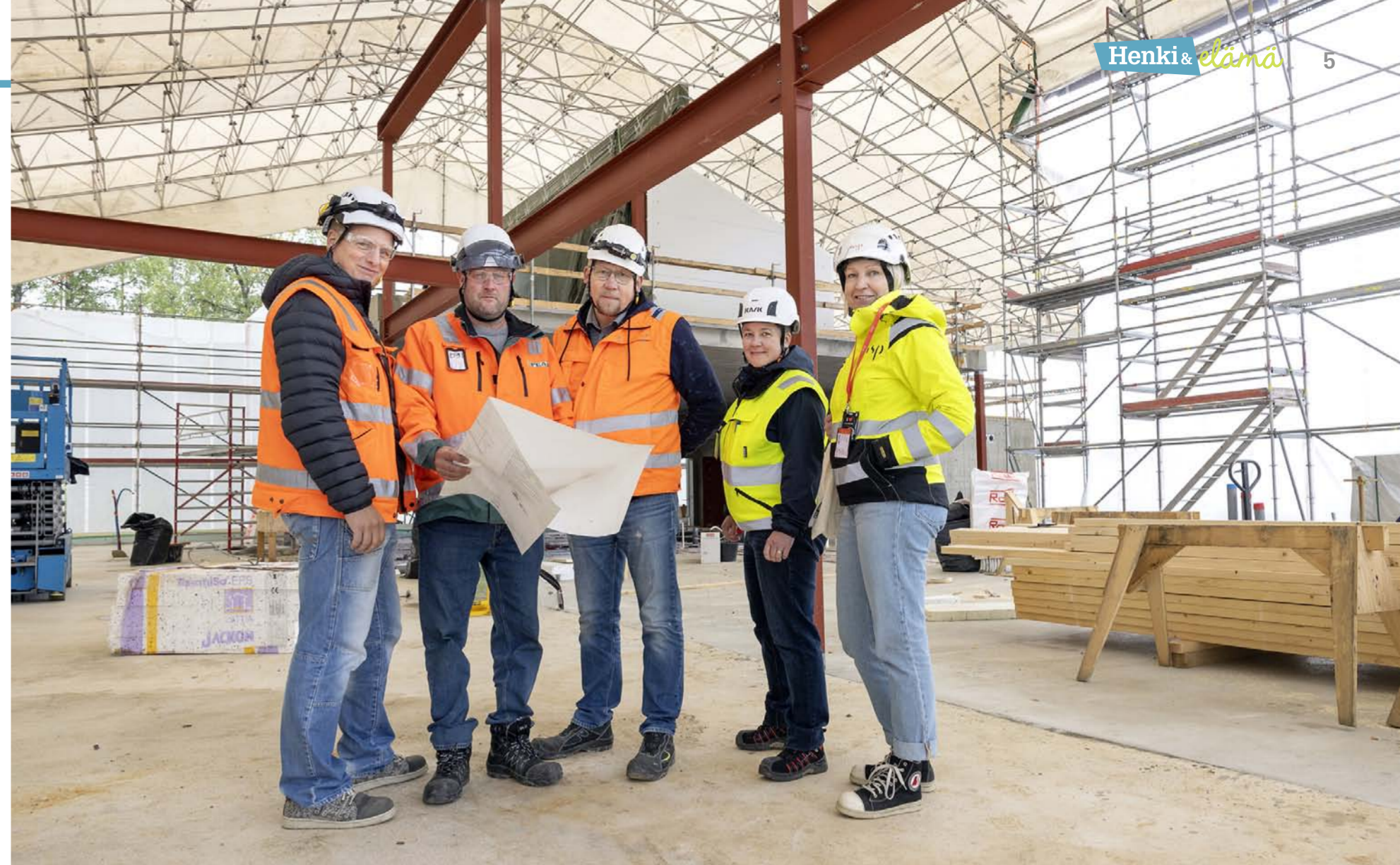
Pääarakennus odottaa sääsuojan sisällä puurungon asentamista. Työpäällikkö Jyrki Pohjosaho (Peab Oy), vastaava työnjohtaja Juha Pietiläinen (Peab Oy), Valvoja Juha Martikainen (Brado Oy), rakennuttajainsinööri Maija Linnala (Jyväskylän seurakunta) ja rakennusvaiheen arkkitehti Sanna Kallantie (WSP Finland Oy) tutkaillevat piirustuksia.
